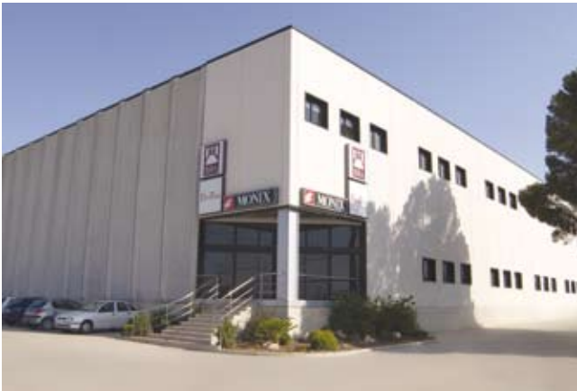
Stabilimento in Valls (Tarragona Spagna)_Valls (Tarragona Spain) Plant
